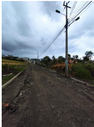
“CALLE (S64) CALLE F”
