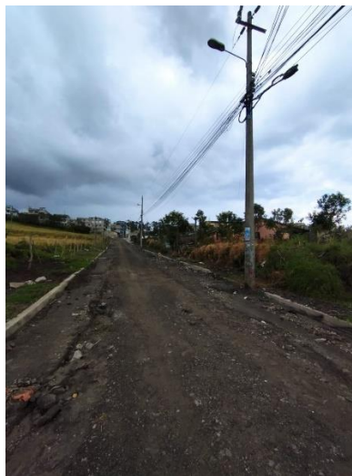
“CALLE (S64) CALLE F”
