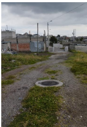
“Calle A” de la Propuesta Urbanística Fotos tomadas durante la inspección.
